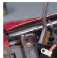
4. De batterijpolen en kabelaan-sluitingen proper maken.
